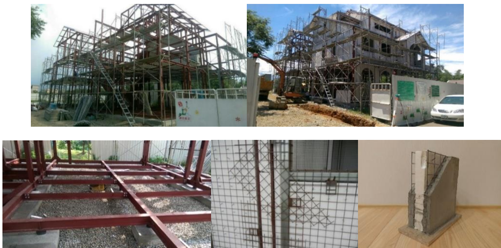
圖 26 雅緻創新複合構造結構施工
